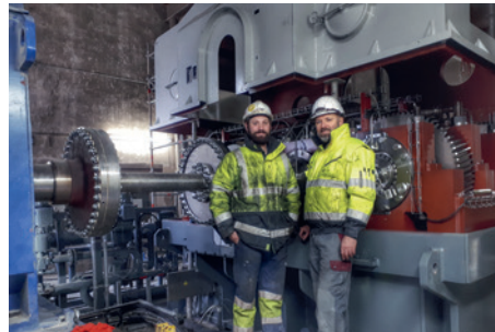
Das Servicespektrum reicht von Inbetriebnahmen über Reparaturen bis zu Inspektionen
